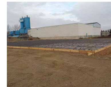
Przygotowanie placu budowy
