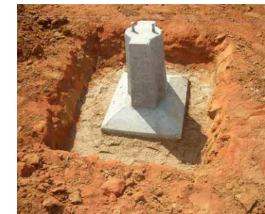
Prefabrykowane stopy betonowe
